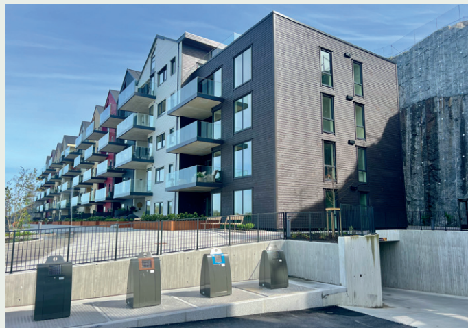
Nedkjørselen til parkeringskjelleren, og parkeringskjelleren i seg selv, er støpt for å tåle høyvann og havnivåstigning.
